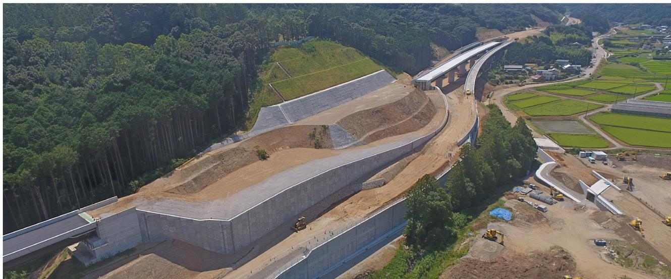
【表彰理由】大規模切土の施工と同時期に金野IC前後の擁壁工を施工する工程上の制約がある中、前後に位置する他工事の現場内通行経路を確保しつつ補強土壁等を完成した。
