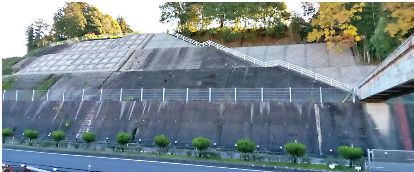
【表彰理由】現道際の法枠工、地山補強土工、アンカー工の施工において、経験豊かな作業員を配置し、法面工の品質確保や向上に寄与した。[担当工事:法面工(法枠工ほか)]
