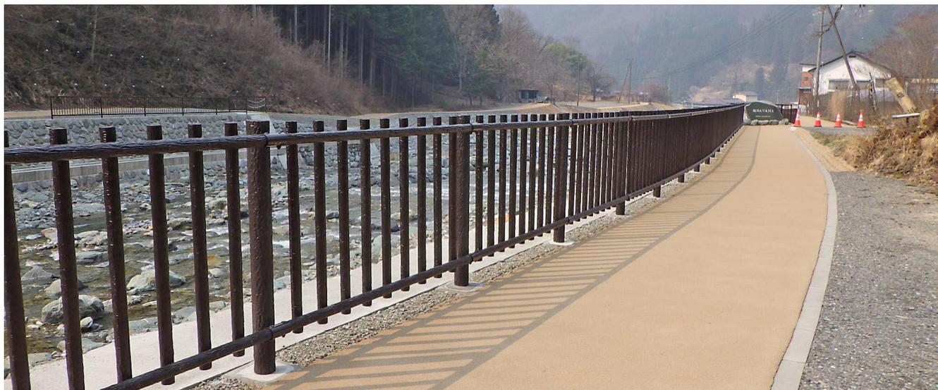
【表彰理由】土系薄層カラー舗装の施工にあたり、温度管理が重要な冬期の施工などの条件に対して、経験豊かな作業員を配置することにより、舗装工の品質確保や向上等に寄与した。[担当工事:付帯道路工(土系薄層カラー舗装)]
