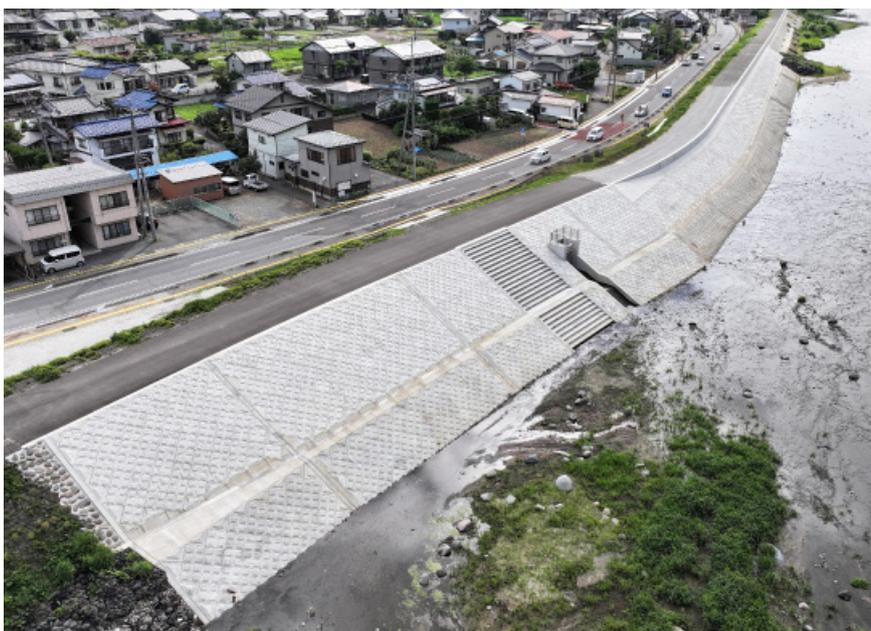
【工事概要】 樋門新設1基、フラップゲート工一式、旧樋門撤去3基、取付け水路工 147m、築堤・盛土1,300m<sup>3</sup>、既設護岸撤去工一式、法覆護岸工1,340m<sup>2</sup>、根固工一式、特殊堤工80m、仮設工一式
